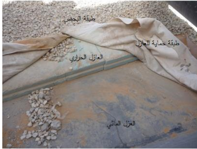
شكل 2-11. العازل الحراري فوق العازل المائي لسطح كلية الهندسة بجامعة القصيم عام 2012 [4].
