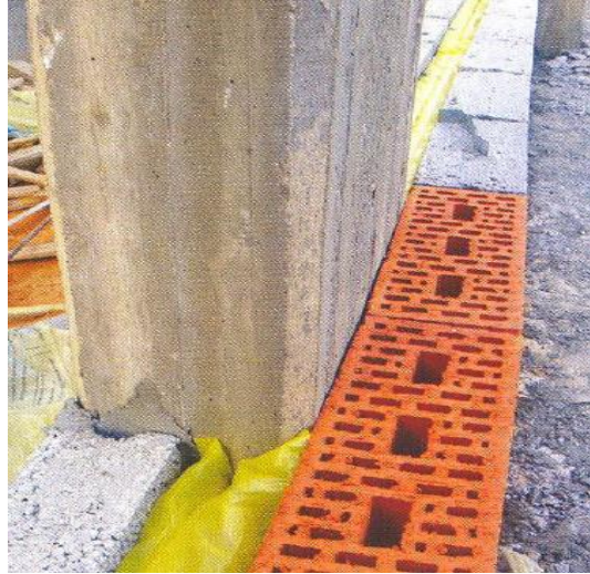
شكل 2-16. صورة لكيفية عزل جدار خارجي بطبقة عازلة وسط الجدار [4].
