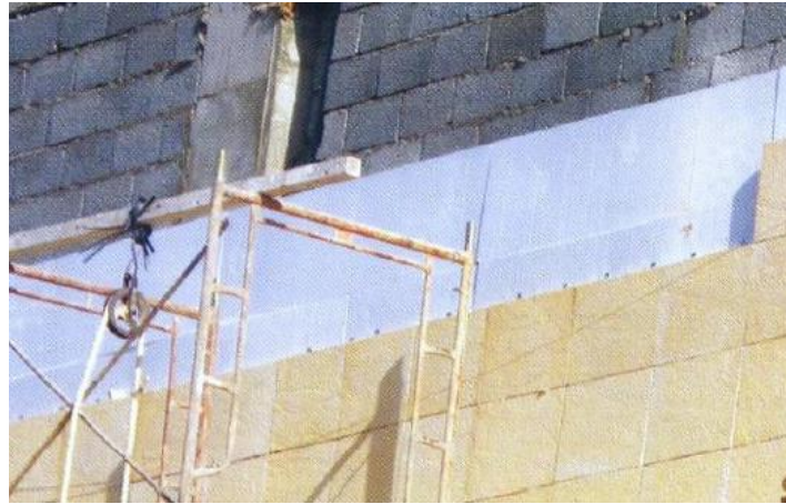
شكل 2-17. صورة لواجهة بناء معزول بشكل كامل [4].
