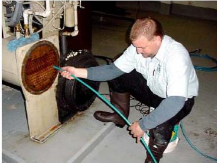
طريقة شطف مواسير المكثف بعد إذابة الترسبات
