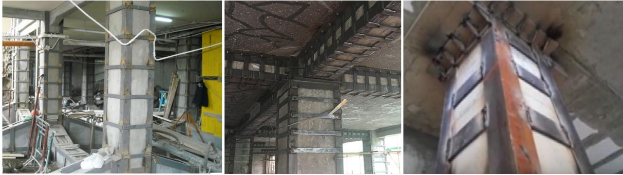
الشكل (17-1) تدعيم الاعمدة باستخدام القمصان الفولاذية
