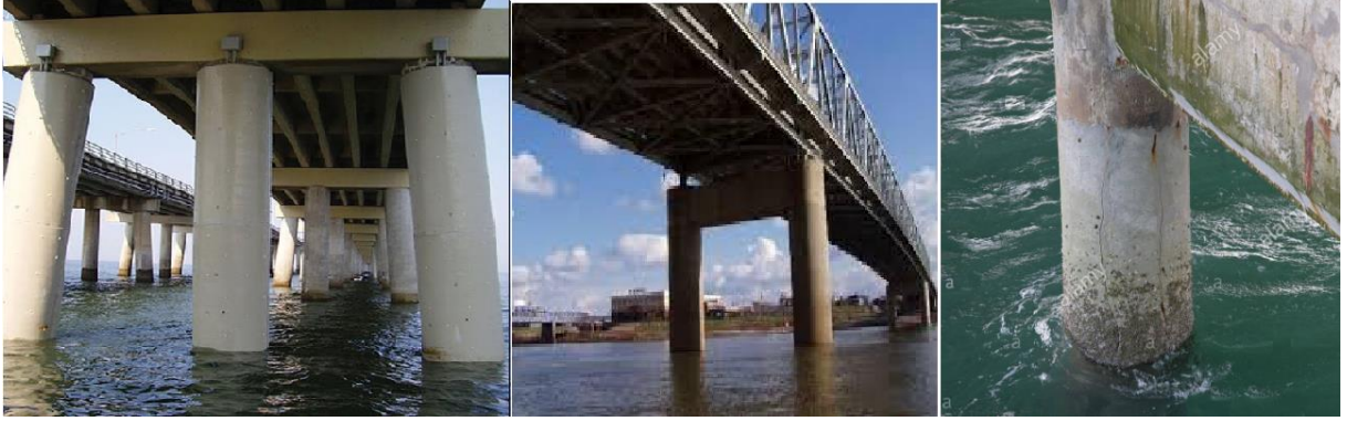
الشكل (3-1) استخدام الأعمدة الدائرية في ركائز الجسور النهرية وفي الأرصفة البحرية
