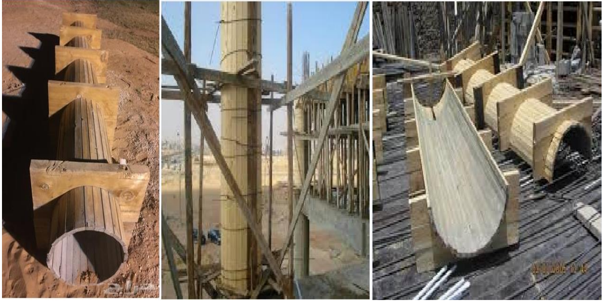
الشكل (9-1) استخدام القوالب الخشبية لتنفيذ الأعمدة الدائرية
