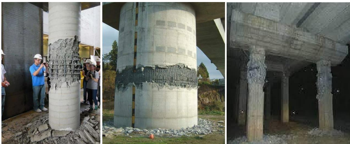
الشكل (10-1) تضرر الأعمدة الدائرية بسبب ازدياد حملاتها عن القيم التصميمية
