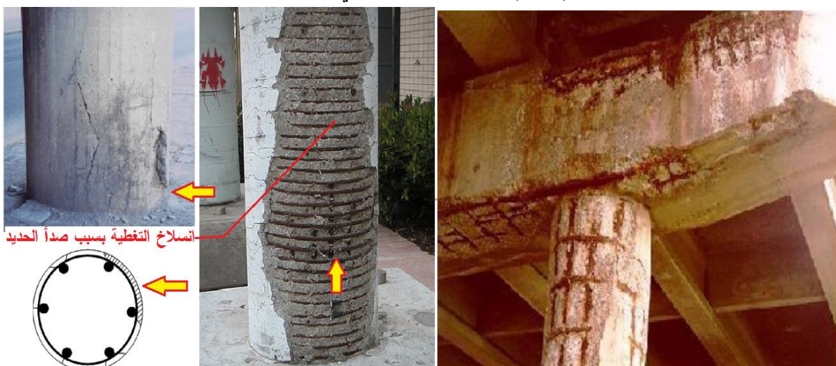
الشكل (12-1) تضرر الأعمدة الدائرية وانسلاخ التغطية بسبب صدأ حديد التسليح
