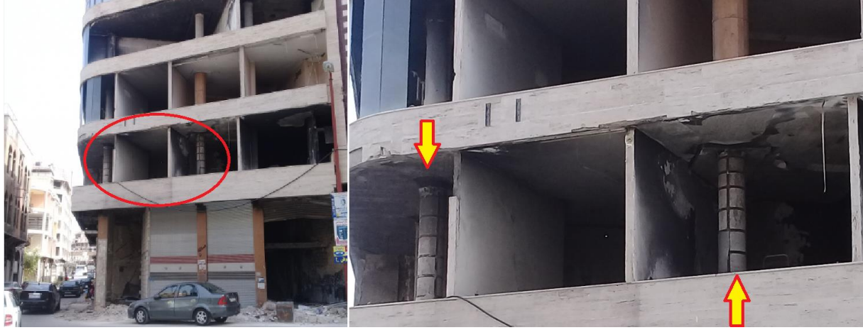
الشكل (18-1) استخدام التدعيم بالقمصان الفولاذية في بناء متضرر نتيجة الحريق في المبنى المقابل لمبنى نقابة المهندسين (حي باب هود - مدينة حمص)
