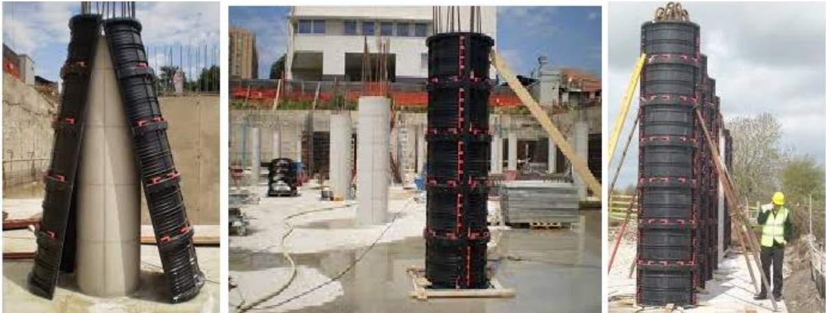
الشكل (7-1) استخدام القوالب البلاستيكية لتنفيذ الأعمدة الدائرية
