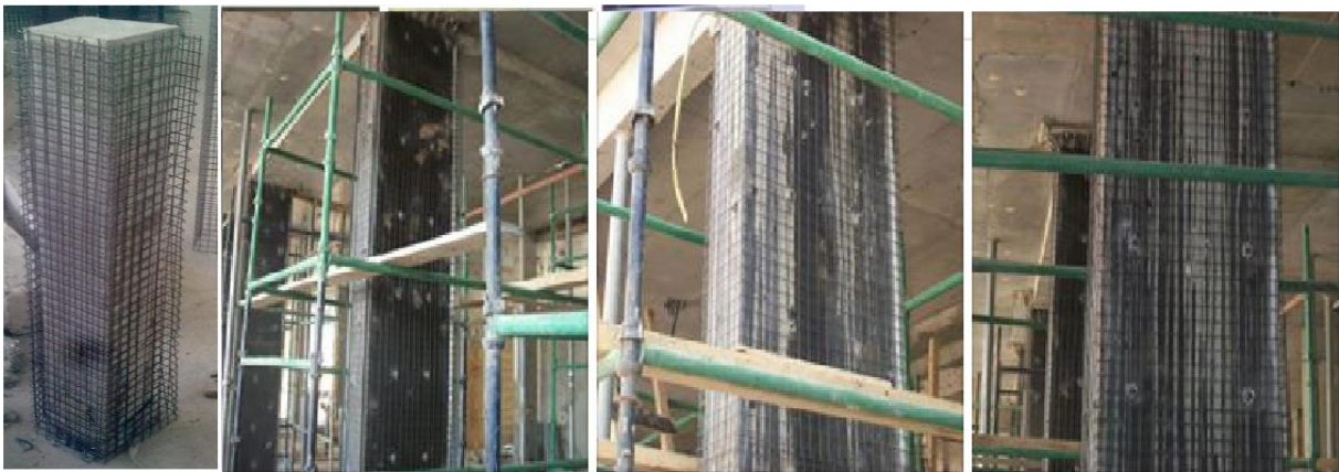
الشكل (15-1) تدعيم الاعمدة بالفيروسمنت
