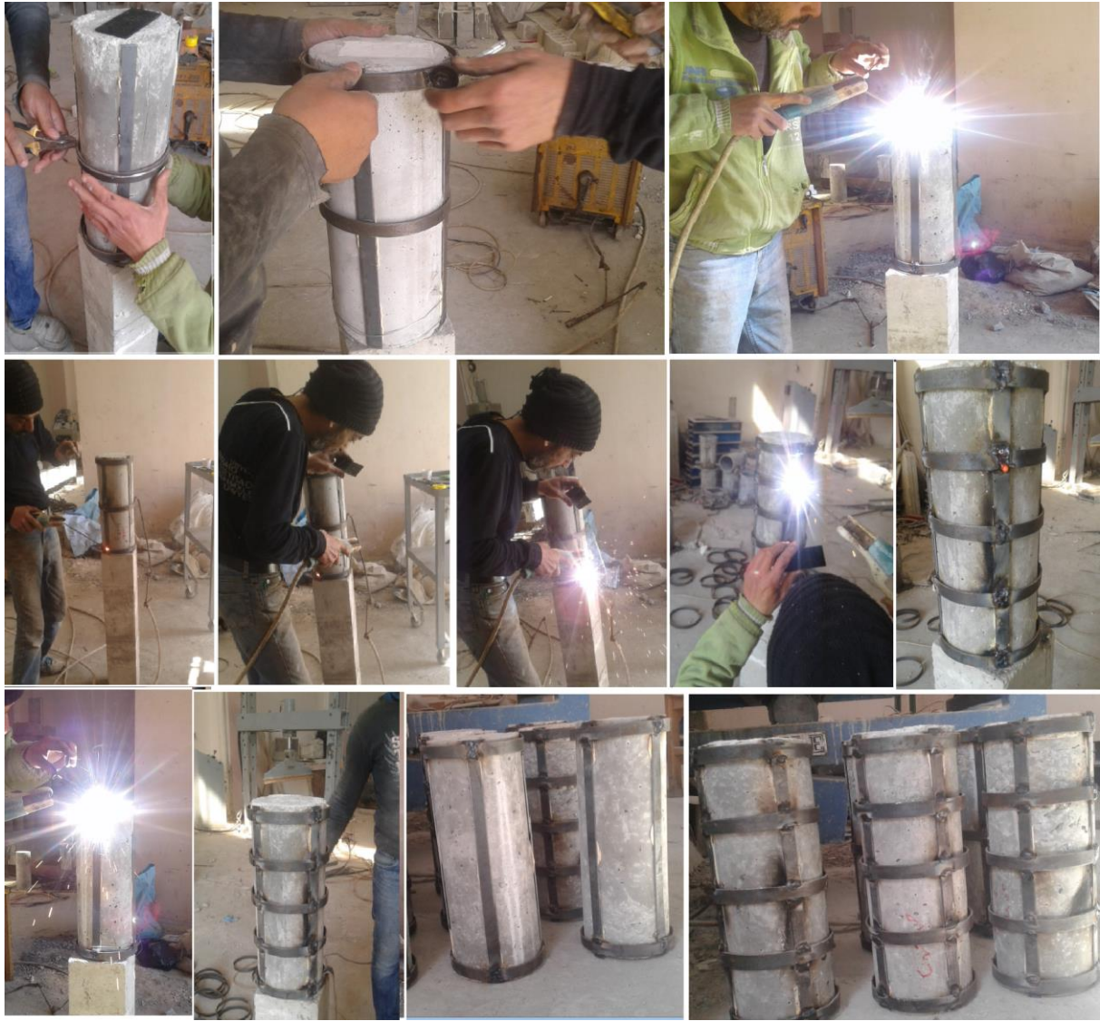
الشكل (3-28) مراحل تدعيم الأعمدة البيتونية المسلحة الدائرية ولحام الصفائح الحلقية
