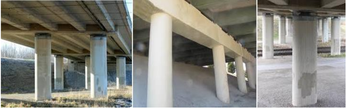
الشكل (2-1) استخدام الأعمدة الدائرية في ركائز الجسور الطرقية
