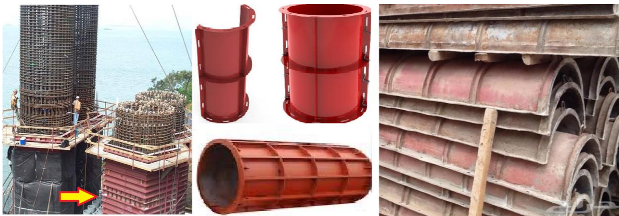
الشكل (8-1) استخدام القوالب المعدنية لتنفيذ الأعمدة الدائرية
