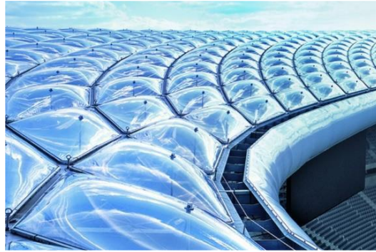
شكل (2-47) ستاد أرينا في ميونخ يوضح وحدات البوليمير المنفوخة و المزدوجة - المرجع : خيطو ، علا ، مفهوم العمارة التكيفية و تطبيقاتها على أغلفة الأبنية
