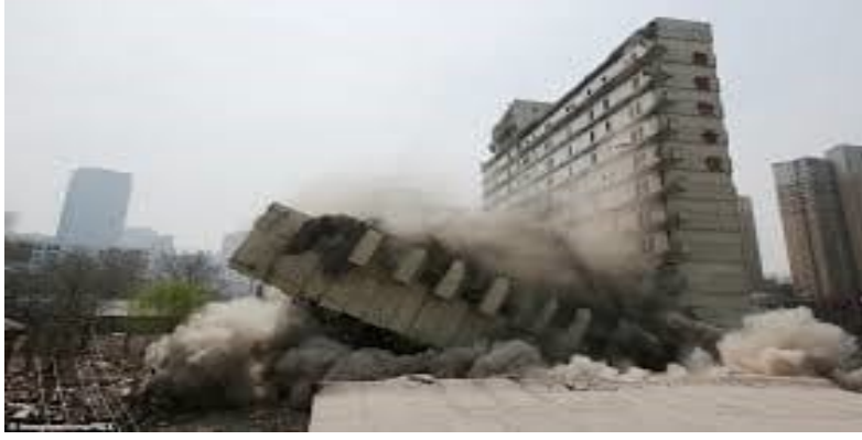
الشكل 3-7: سقوط المبنى مثل الشجرة عند تفجيره.
