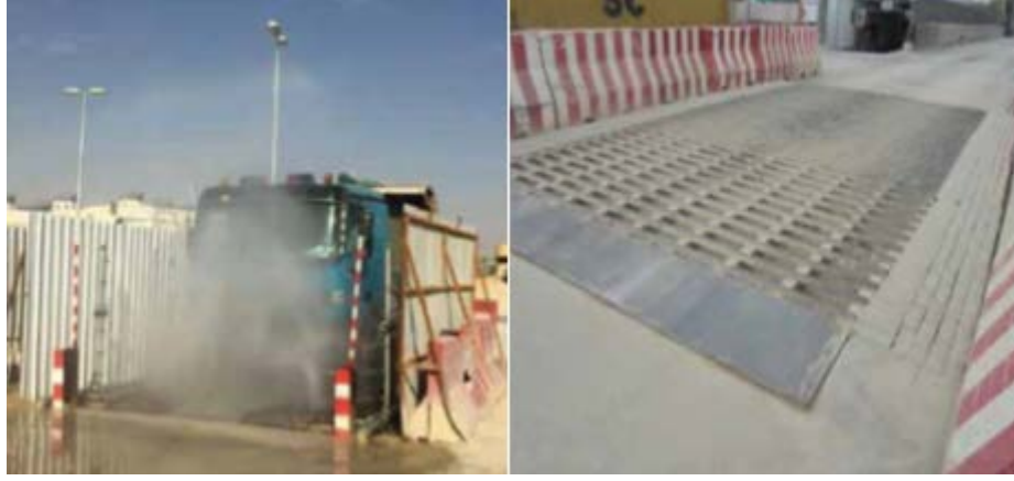
الشكل 3-22: غسل الشاحنات عند مخارج المحطة.
