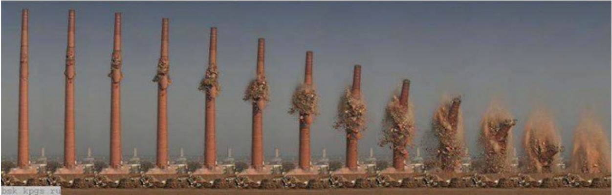
الشكل 3-8: سقوط المبنى بشكل رأسي.
