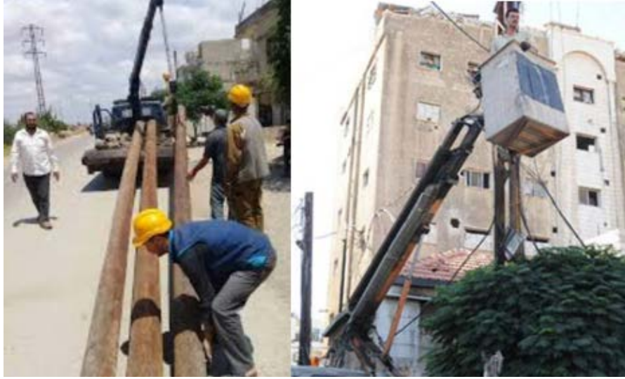
الشكل 3-13: صيانة خطوط الكهرباء.
