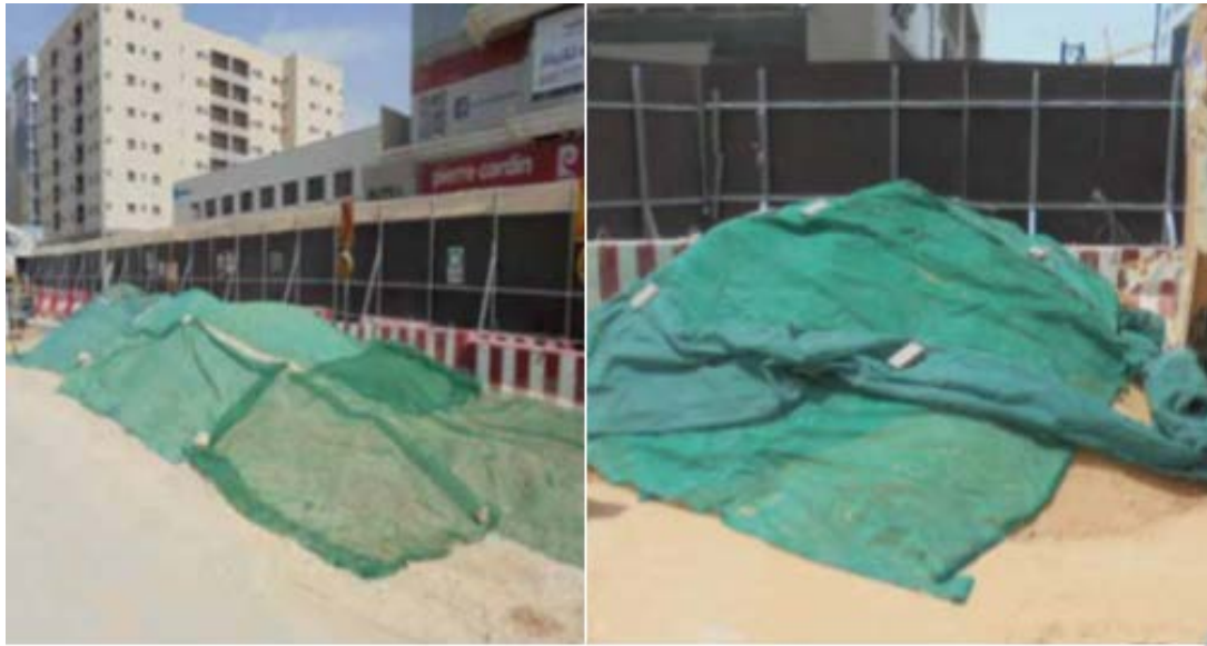
الشكل 3-25: تغطية المواد الناعمة.
