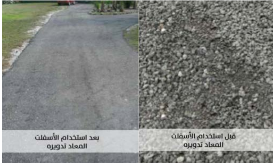
الشكل 3-26: استخدام المواد المعاد تدويرها في تعبيد الشارع.
