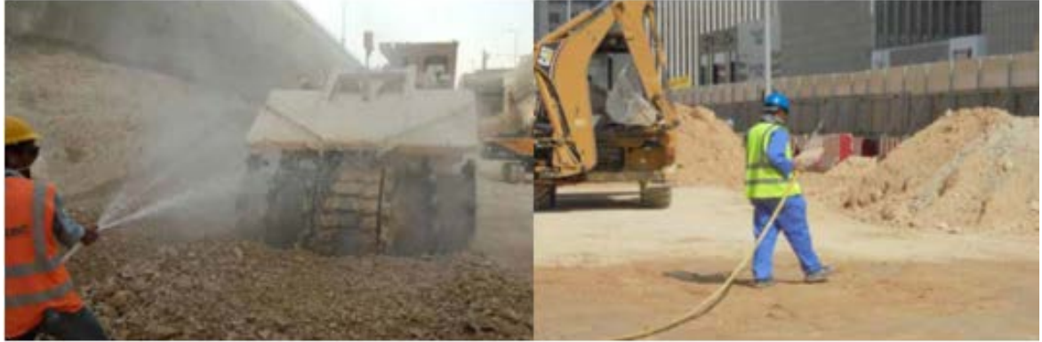
الشكل 3-23: رش المياه لمنع تطاير الغبار في موقع العمل.
