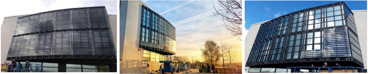
الشكل ( 3-7 ) استخدام الفتحات الكهروضوئية في مكاتب Tecnalia في San Sebastian ، إسبانيا.
