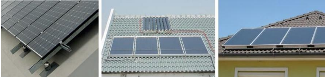
الشكل (3-20): تركيب السطح الشمسي أمام السقف المستوي المائل
