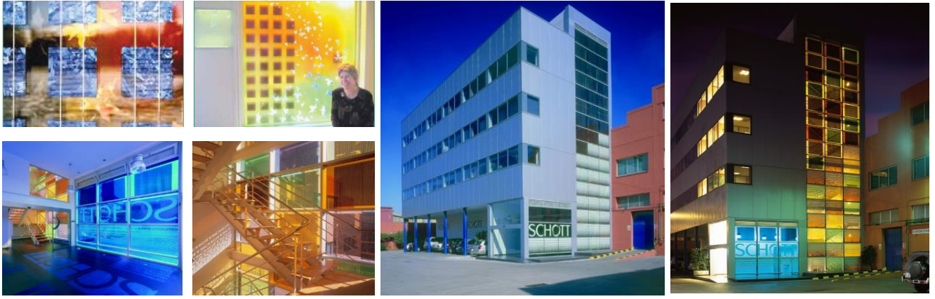
الشكل ( 2-3 ) تحقيق القيمة الضوئية الطبيعية والصناعية بشفافية الخلايا الكهروضوئية في واجهة مبنى شركة Solar façade
