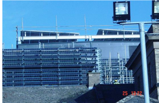
الشكل ( 4-10 ) يوضح تركيب الخلايا الكهروضوئية على الكاسرات والاسقف
