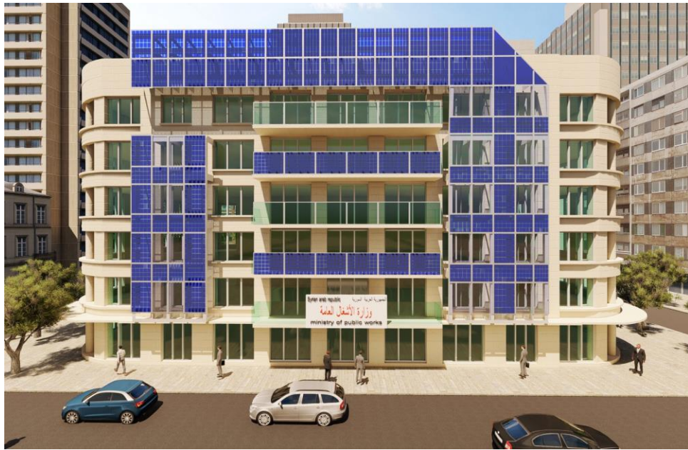
الشكل : ( 5-6) تركيب الألواح الكهروضوئية على الواجهة الجنوبية لمبنى وزارة الأشغال العامة والإسكان
