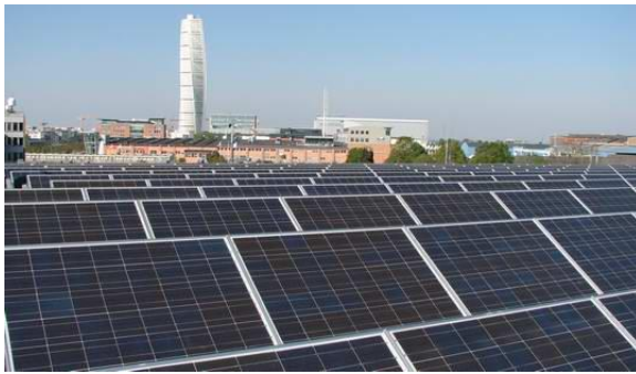
الشكل ( 4-33 ) كيفية وضع الألواح الكهروضوئية على سقف المتحف مائلة باتجاه اشعة الشمس-المصدر(58) :
