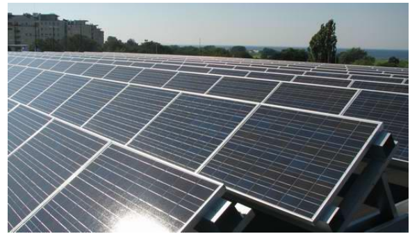
الشكل ( 4-33 ) كيفية وضع الألواح الكهروضوئية على سقف المتحف مائلة باتجاه اشعة الشمس-المصدر(58) :
