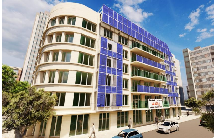
الشكل : ( 5-7) لقطات خارجية مقترحة لتركيب الألواح الكهروضوئية على الواجهة الجنوبية مبنى وزارة الأشغال العامة والإسكان المصدر : عمل الباحث
