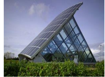
الشكل ( 3-24 ) مرونة التشكيل المعماري باستخدام الاسقف المنحنية الكهروضوئية بمبنى The BP solar Showcase في برمنغهام
