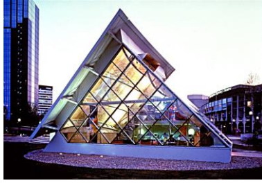
الشكل ( 3-24 ) مرونة التشكيل المعماري باستخدام الاسقف المنحنية الكهروضوئية بمبنى The BP solar Showcase في برمنغهام
