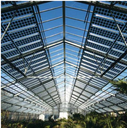
الشكل (3-22):السطح الشمسي يشكل كامل السقف المستوي المائل
