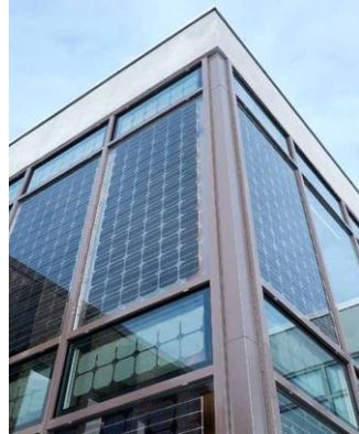
الشكل ( 3-14 ) : تركيب الخلية الكهروضوئية على الجدار
