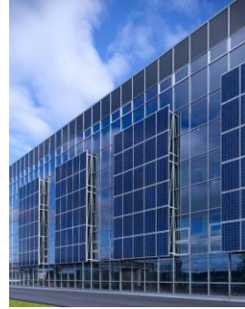
الشكل (3-13): تركيب الخلايا الكهروضوئية أمام الجدار
