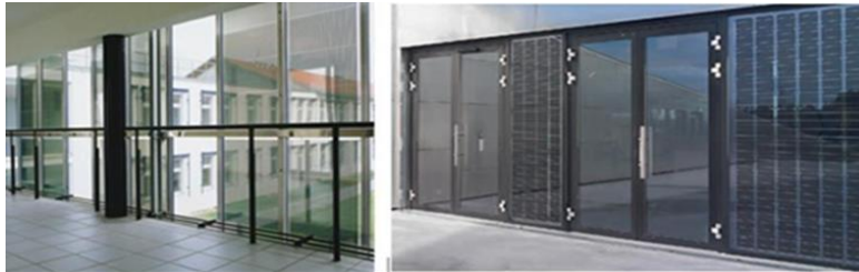
الشكل ( 3-8 ) :السطح الشمسي الشفاف يشكل كامل الفتحات
