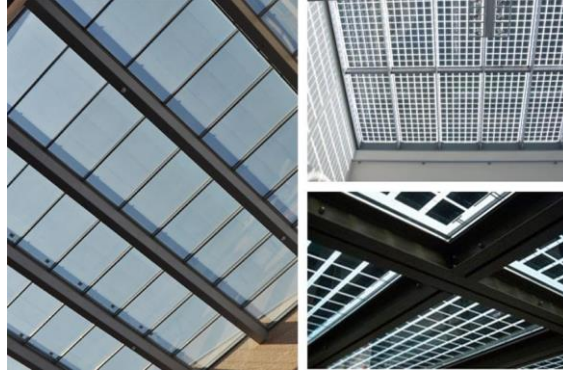
الشكل (3-19): السطح الشمسي يشكل كامل السقف المستوي الأفقي
