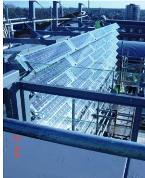
الشكل ( 4-10 ) يوضح تركيب الخلايا الكهروضوئية على الكاسرات والاسقف
