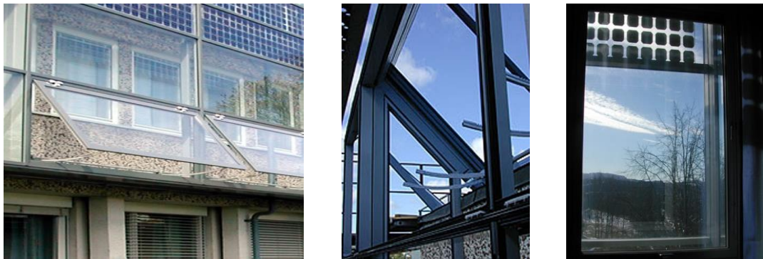
الشكل ( 49-4 ) يوضح كيفية توضع الخلايا امام الواجهة وامكانية فتحها للتهوية
