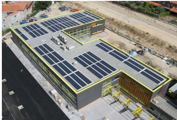
الشكل ( 3-16 ) : كيفية تركيب الخلايا الكهروضوئية على سقف مركز الاطفال "Bhima Sangha" في اسبانيا
