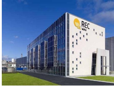
الشكل (3-13): تركيب الخلايا الكهروضوئية أمام الجدار
