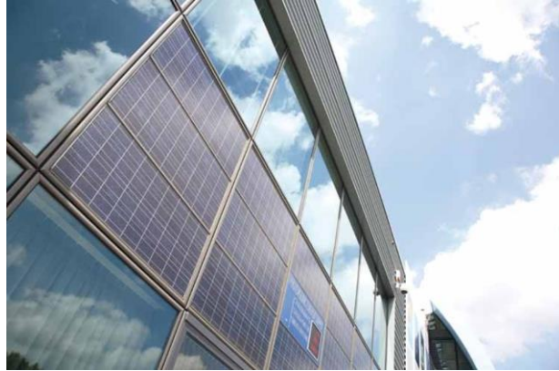
الشكل ( 3-15 ) : تركيب الخلية الكهروضوئية كجزء من الجدار
