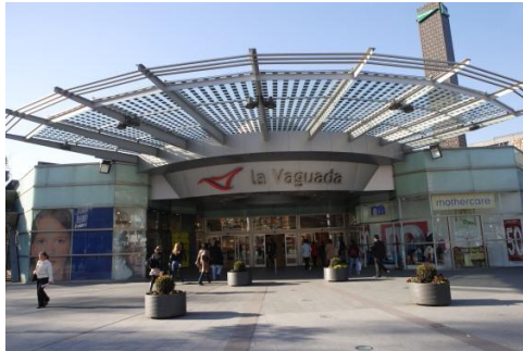
الشكل (3-6): دمج الخلايا الكهروضوئية بهيئة وحدات شفافة في مظلة المركز التجاري الترفيهي
