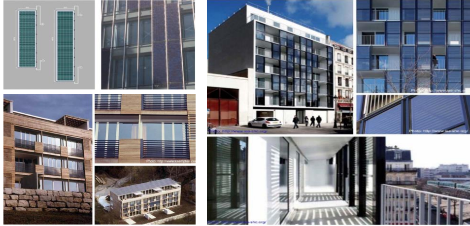
الشكل ( 3-9 ) : تركيب السطح الشمسي أمام الفتحات
