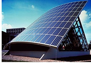
الشكل ( 3-24 ) مرونة التشكيل المعماري باستخدام الاسقف المنحنية الكهروضوئية بمبنى The BP solar Showcase في برمنغهام
