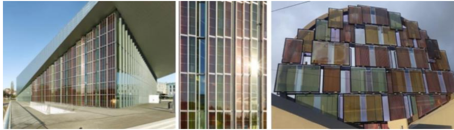
الشكل(1- 27): خلايا السليكون المتعدد البلورة والخضراء اللون لصالح، Paul-Horn ، Tubingen المانيا
